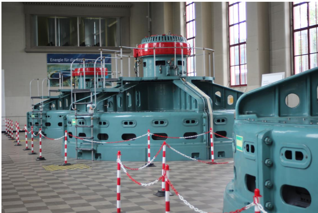
Total fünf Maschinen stehen in den beiden Kraftwerken im Einsatz
