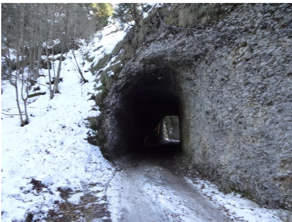
Das Hegeloch wurde 1839/40 durch die Bauern der Umgebung mit altem Bernpulver ausgesprengt
